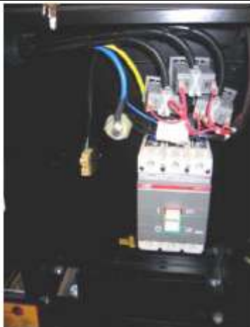
Рис. 1: Открытая электрическая панель
