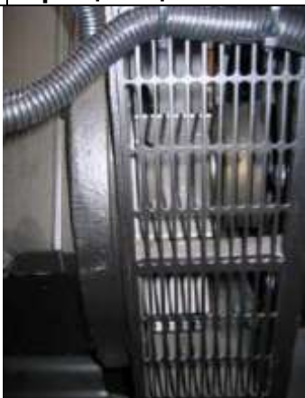
Рис.3 Зона генераторного вентилятора и стыковочных частей
